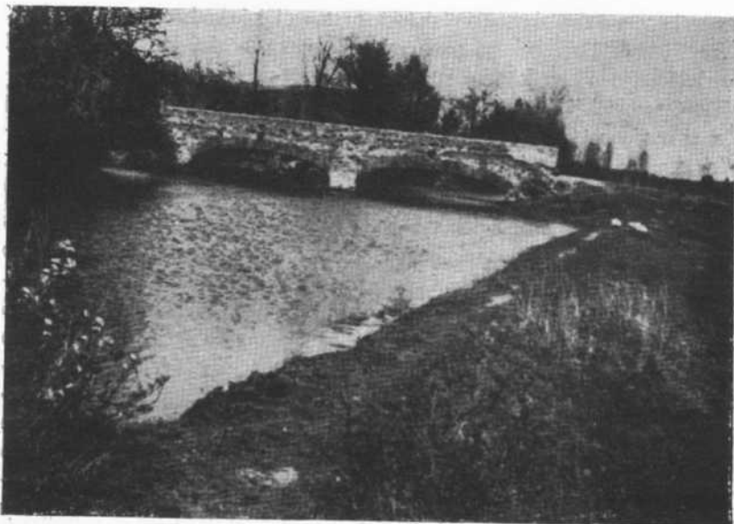
Kamenný most přes kanál v Podůšanech
